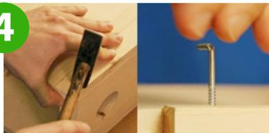
Vorderseite einsetzen. Oben mit zwei Nägeln so an den Seitenwänden befestigen, dass sie sich ausklappen lässt. Unten zwei Schraubhaken zur Sicherung der Vorderseite in die Seitenwände drehen.
