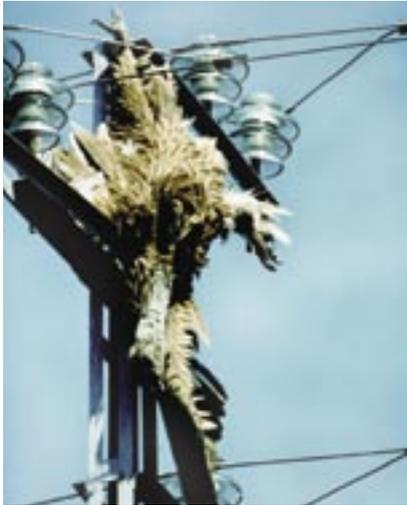
Mit seiner enormen Spannweite hat dieser Gänsegeier (*Gyps fulvus*) mindestens einen der unter Spannung stehenden Leitungen berührt und einen tödlichen Erdschluss erzeugt.
