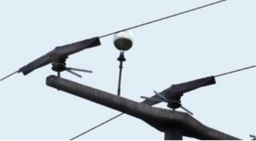
*Dieser Mast wurde zunächst mit einer Spiegelglaskugel, später mit Kunststoff-Vogelabweisern versehen. Erst beim dritten Anlauf wurden die Isolatoren mit wirksamen Isolier-Abdeckhauben ausgerüstet.*
