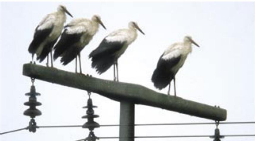
Masten von Mittelspannungs-Freileitungen (zwischen 1kV und 60 kV) können dann als relativ vogelsicher gelten, wenn der Abstand zwischen einem möglichen Sitzplatz der Vögel und den unter Spannung stehenden Teilen mehr als 60 cm beträgt. Am besten sollten Leitungen an langen Hängeisolatoren unterhalb der Traverse verlaufen. Prinzipiell gibt es solche Konstruktionen bereits seit Jahrzehnten.
