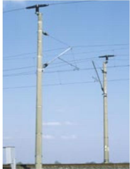
*Ein beliebter, aber gefährlicher Sitzplatz für Vögel: der Oberleitungsmast der Deutschen Bahn AG. Die unter Spannung stehende Einspeiseleitung ist über der Mastspitze angebracht. Die Leitung wurde später durch 1,30 m lange Isolierkappen auf den Stützisolatoren entschärft.*
