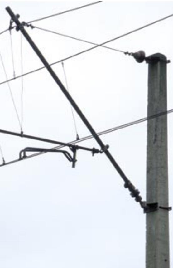
*In Osteuropa weit verbreitet: Der Mastkopf der Bahnleitung ist nur durch einen sehr kurzen Isolator von den unter Spannung stehenden Teilen getrennt.*
