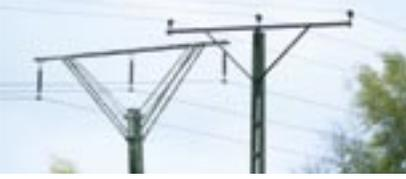
*Nur der linke Mast mit Hängeisolatoren ist sicher. Maßnahmen zum Schutz vor Stromschlag machen aber nur dann Sinn, wenn sie konsequent und flächendeckend eingesetzt werden.*
