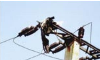
Die verheerende Wirkung gefährlich konstruierter Strommasten zeigt auch ein Beispiel aus Kasachstan: An einem elf Kilometer langen Abschnitt einer Mittelspannungsleitung in einem Naturschutzgebiet am Tengiz-See wurden allein im Oktober 2000 zahlreiche Vögel als Stromschlagopfer registriert, darunter 200 Turmfalken, 48 Steppenadler, zwei Kaiseradler, ein Seeadler und ein Mönchsgeier.
