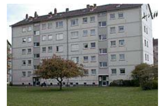
Typisches Beispiel für sanierungsbedürftigen Wohnungsbestand der 50er und 60er Jahre (Quelle Öko-Institut e.V.)
