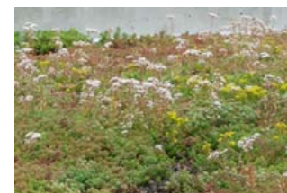
Die extensive Dachbegrünung sorgt für ein lokal verbessertes
