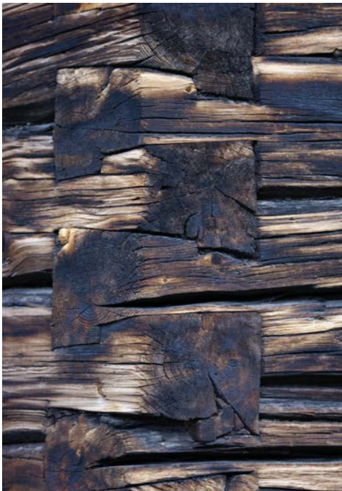
Abb. 1 Hält und hält und hält...: Holzverbindung eines der rund 300-jährigen Blockhäuser der norwegischen Bergwerksstadt Røros
