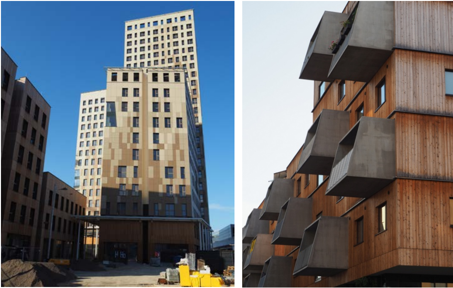
Abb. 6 (li.) Das Wiener Hoho mit Eternit-Fassade und sein linkes Nachbargebäude mit sichtbarer Holzfassade
