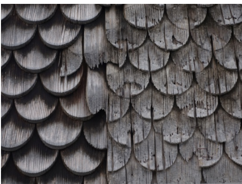
Abb. 5 Moderne Holzschindelfassade – Die Schindeln links wurden bereits ersetzt, weil sie verwittert waren
