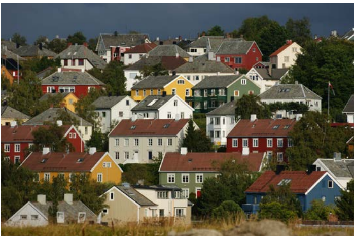
Abb. 3 Mehrgeschossige Wohnhäuser aus Holz in Norwegen
