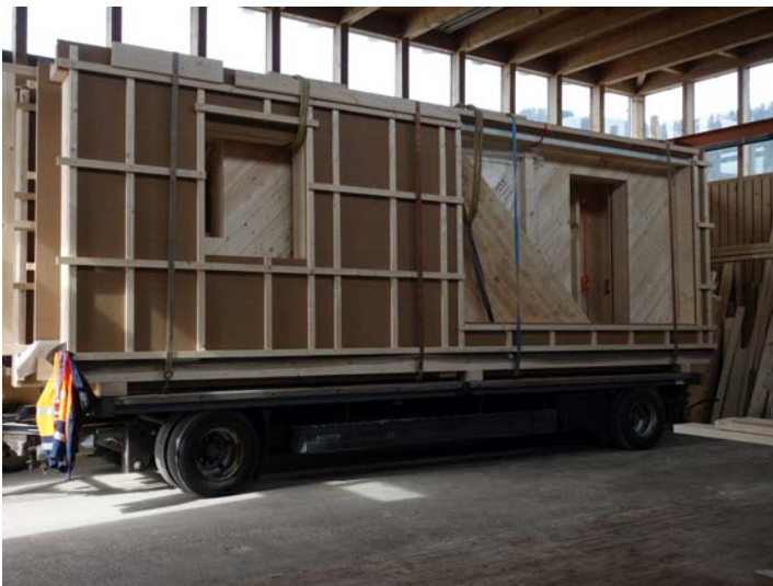
Abb. 8 Im Trockenem vorgefertigt ist ein Holzhaus schnell aufgebaut
