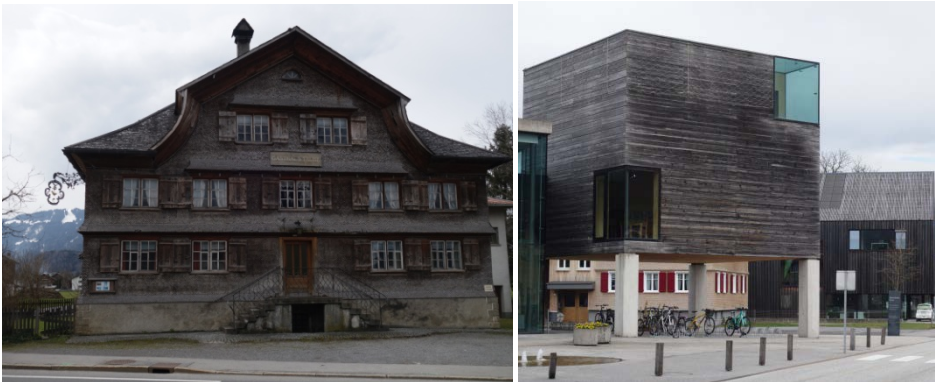
Abb. 4 Traditionelles und modernes Holzgebäude im Bregenzer Wald
