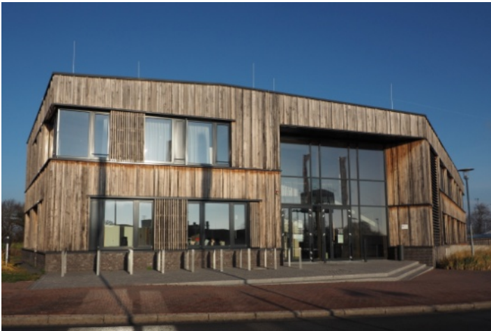
Abb. 11 Ein öffentliches Gebäude, das wegweisend für Ressourceneffizienz steht aus 7.000 Kubikmetern Holz. Die Fassade und viele Teile im Innenausbau stammen aus der Bauteilbörse. Dem Ensemble der Stadtwerke Neustadt in Holstein aus insgesamt drei Gebäuden ging eine Lebenszyklusanalyse voraus, es erfüllt den Standard Null-Emissions-Passivhaus und kostete 10 Millionen Euro.
