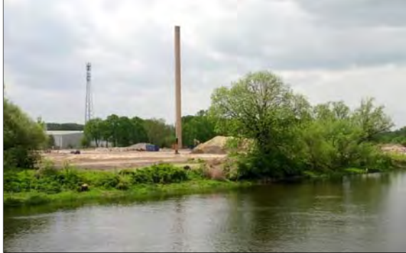
Blick auf die Industriebrache, kurz vor Abschluss der Beräumung Quelle Fotos: Institut für Fluss- und Auenökologie
