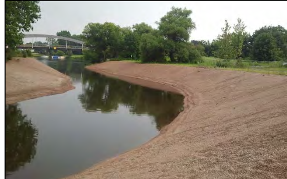
Wieder hergestellter Altarm, kurz nach Fertigstellung
