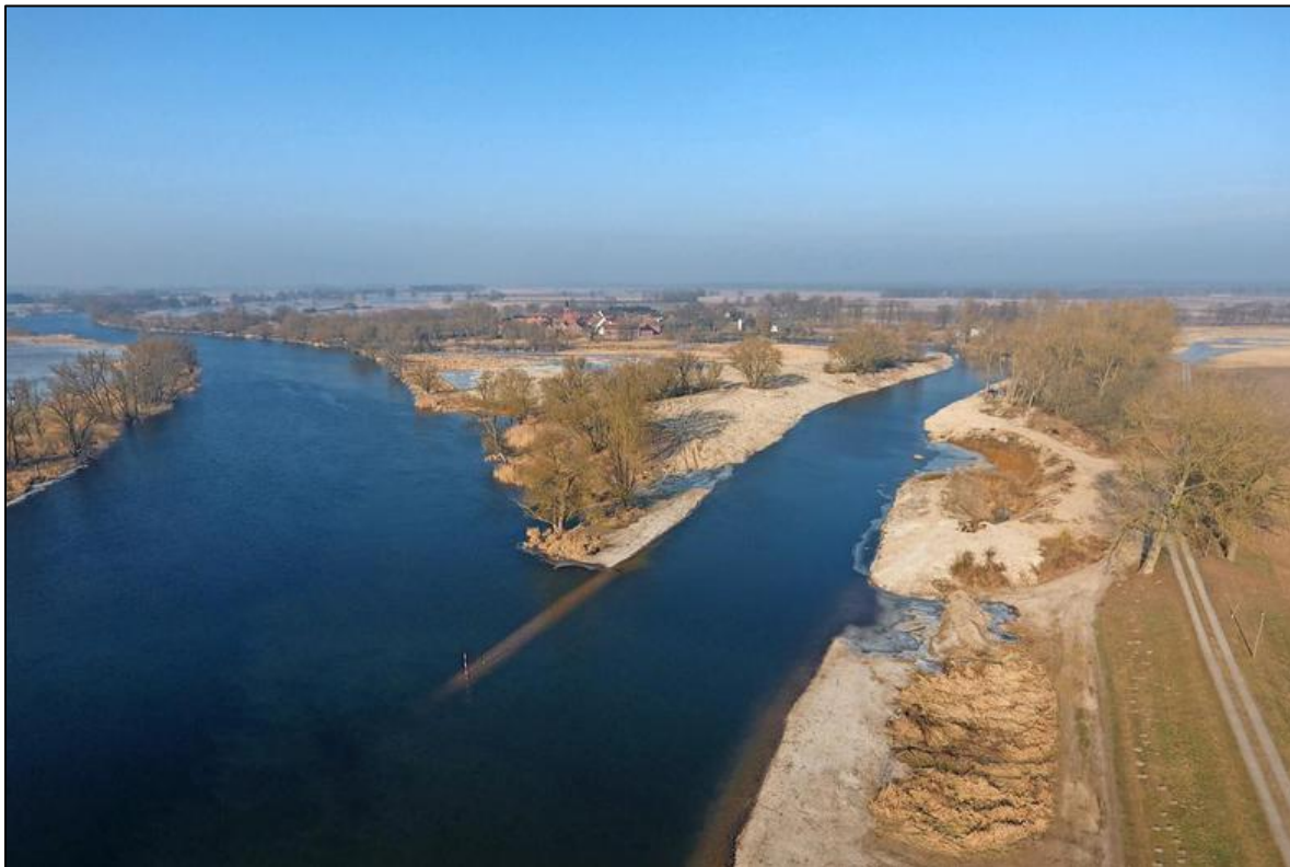
Abbildung: Altarmanschluss nach Fertigstellung
