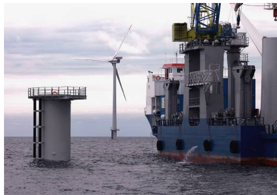
Plattform für Offshore-Anlage von Vestas Central Europe
