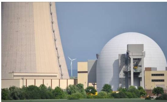
Atomkraftwerk in Grohnde
