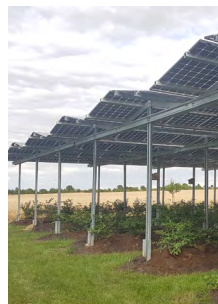
Hochaufgeständerte PV-Anlagen lassen sich mit dem Anbau von Kartoffeln kombinieren.
