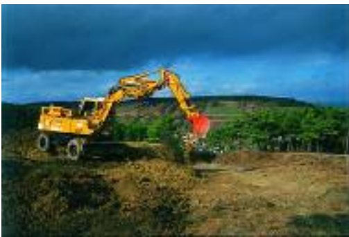
Abtragen des Bodens
