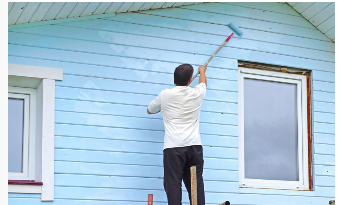
Farben, Lacke und Schutzmittel enthalten oft Biozide, um Holzfassaden, Mauerwerk und Baumaterialien vor Schädlingen und Schimmel zu schützen.
